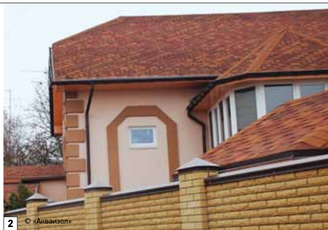
1–2. Благодаря небольшому весу (до 8 кг/м 2 ) и высокой гибкости битумная черепица как никакой другой кровельный материал подходит для крыш сложной конфигурации
